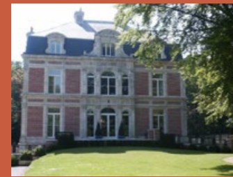
Mairie Château Baratte @villedetempleuve
